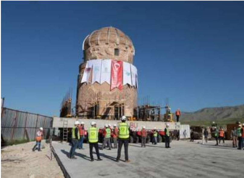
ضريح زينل بك (نقل المبنى الأثري إلى منطقة أخرى بعيدة عن البحيرة) في أيار 2017
